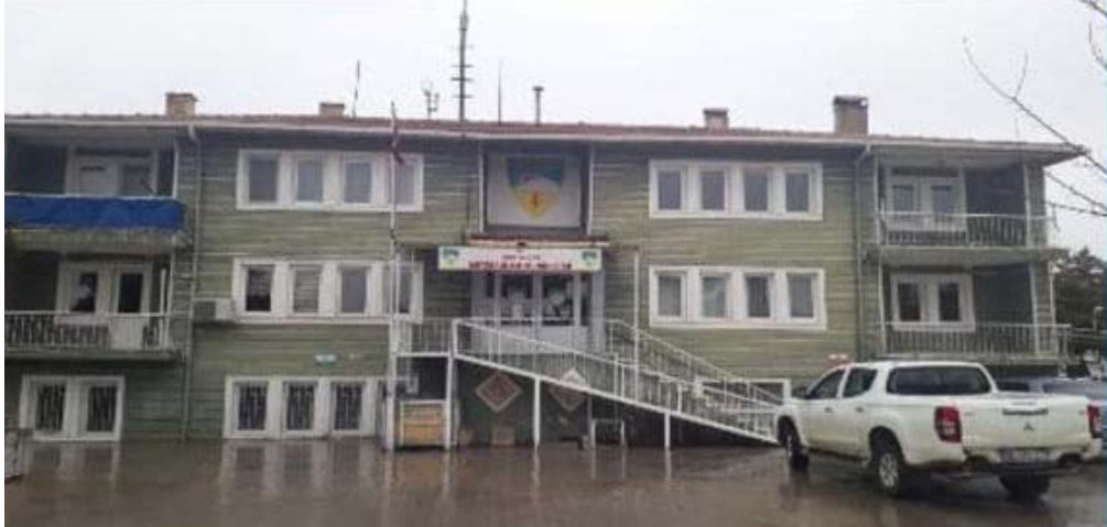
Niğde Meteoroloji Müdürlüğü Hizmet Binası Eski Durumu
