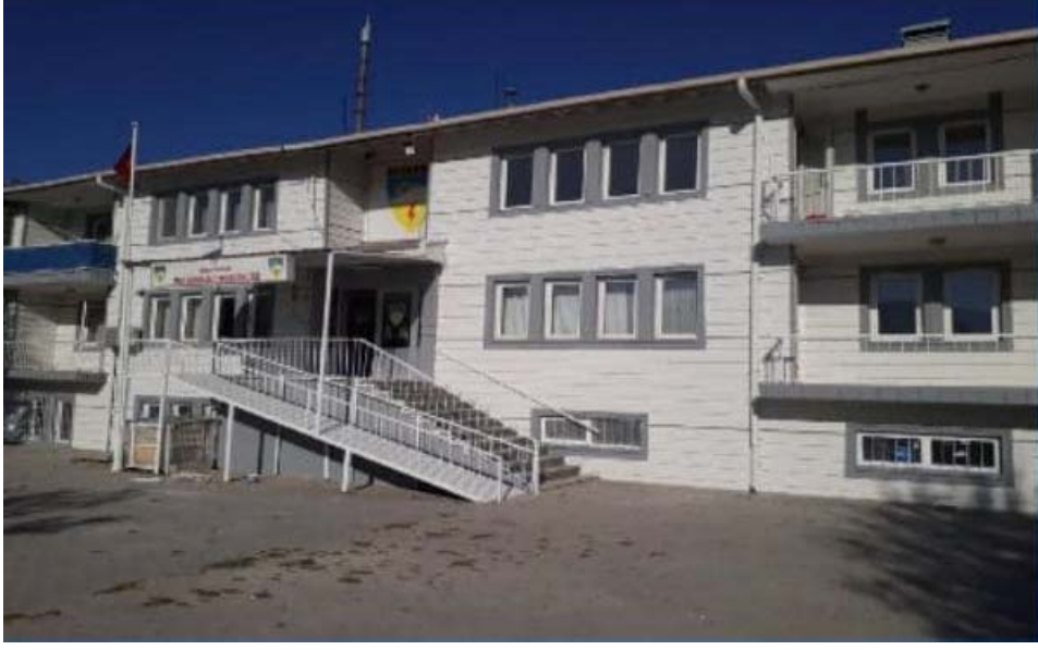
Niğde Meteoroloji Müdürlüğü Hizmet Binası Yeni Durumu
