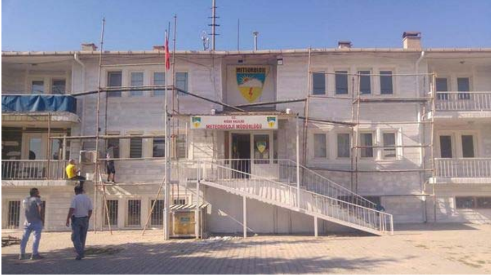
Niğde Meteoroloji Müdürlüğü Hizmet Binası Eski Durumu
