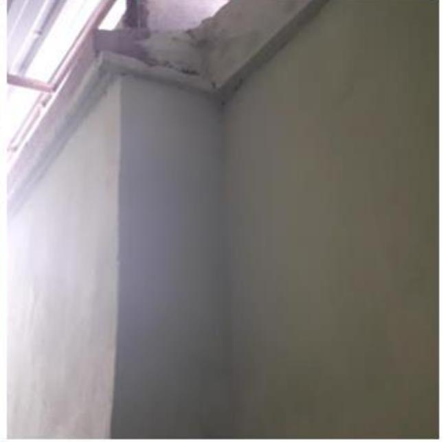
Bina Bodrum Duvarı (Yeni)
