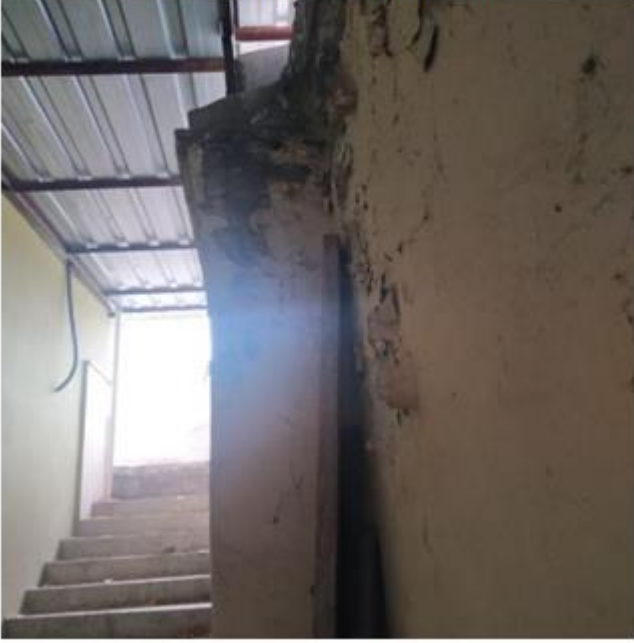
Bina Bodrum Duvarı (Eski)
