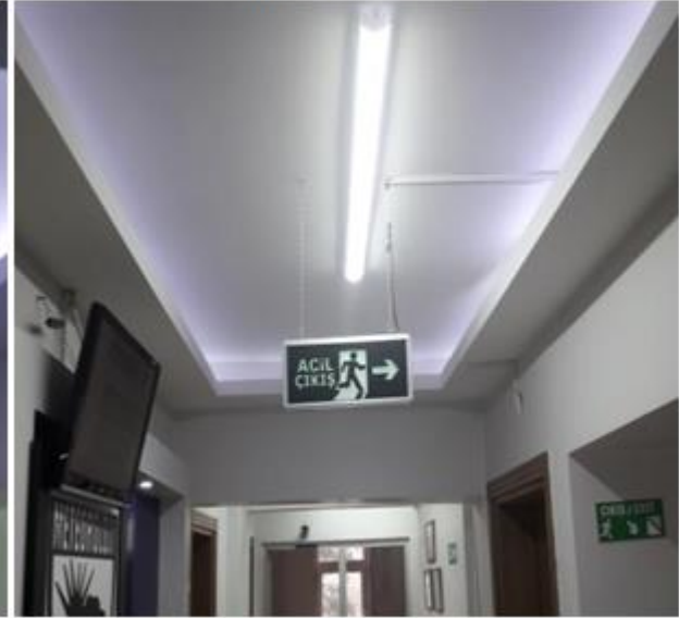
Bina Koridor (Yeni)
